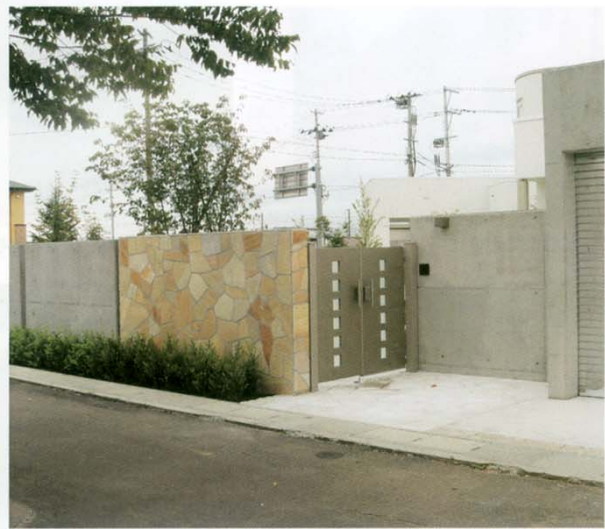
② RCや門扉のグレーに自然石の黄色が映えます。
