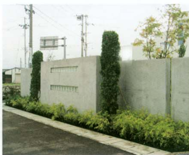
① 目隠しのRCは1箇所ラインをずらし、ガラスブロックの装飾デザイン性のあるものに。
