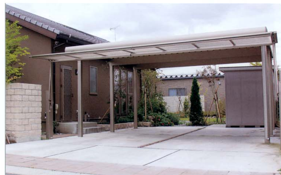
【カーポート】 跳ね上げ門扉を上げたところ。電動式なので操作はスムーズです。カーポートは積雪も考えてG-1を採用。直線的で力強いフォルムが建物や塀とも調和しています。
