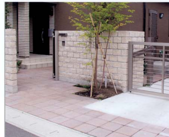
【アプローチにはロードヒーター】 何度か折れ曲がり、外からの距離感をもたせたアプローチ。ピンク色のタイル部分は床下にロードヒーターが埋め込まれ、雪を溶かしてくれるので、雪かきの手間もなく安全に歩けます。
