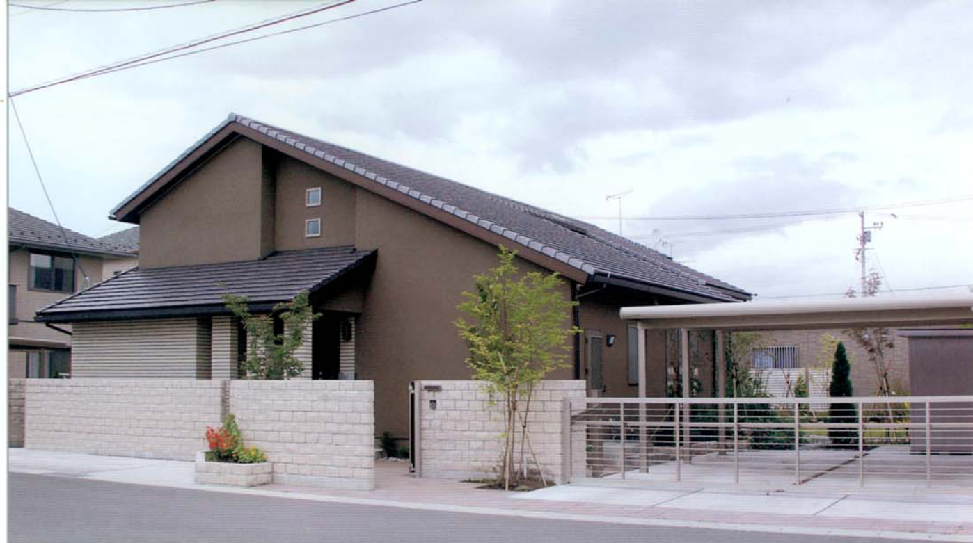
【エクステリア全景】 建物、塀、カーポートがバランスよくまとまった美しい外観。塀は高級感のあるレンガ風のブロックを採用。建物とは対照的な明るい色でアクセントに。
