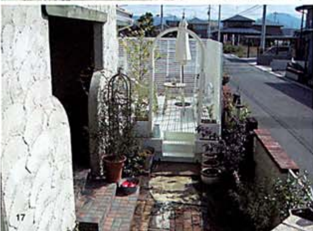
④ 門扉をくぐったところからデッキをのぞんで。外壁(写真左側)に合わせて、塗り壁の塗装もラフな仕上げに(写真右側)。
